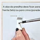
2. Faça os furos nas marcações feitas e aplique as buchas. Posicione a presilha sobre a bucha aplicada e coloque o parafuso com auxílio da chave philips ou parafusadeira.
