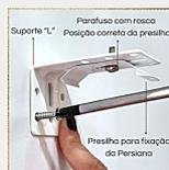
2. Faça os furos nas marcações feitas e aplique as buchas. Posicione o suporte "L" sobre a bucha aplicada e coloque o parafuso com auxílio da chave philips ou parafusadeira.
